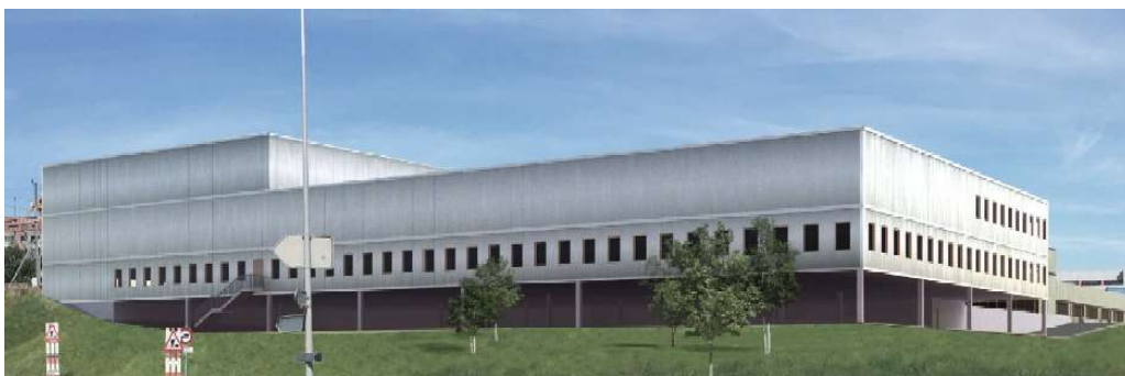
Plateforme logistique Vaud-Genève (PLEXUS-Santé) Chemin de la Mochettaz 22, 1030 - BUSSIGNY-PRES-LAUSANNE
